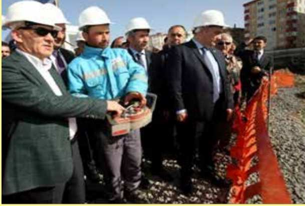
Resim 6-7. Yeni yapılacak binaların temel atımı
